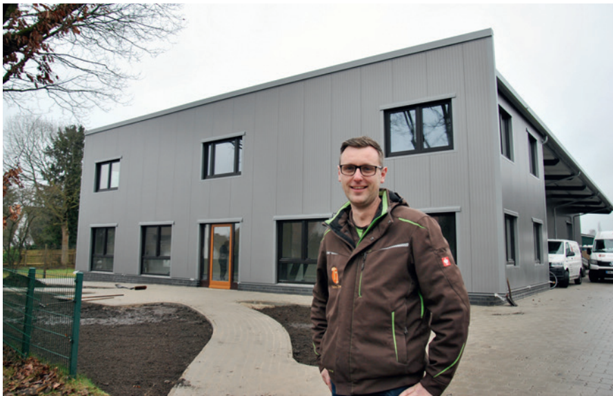
Tobias Zöllner vor dem neuen Betriebsgebäude an der Bremer Landstraße.
